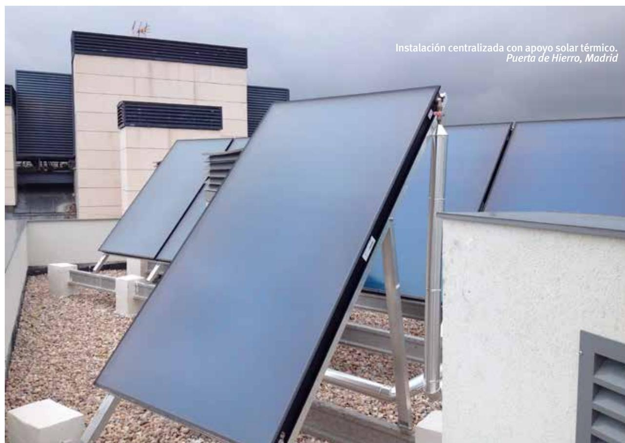
Instalación centralizada con apoyo solar térmico.
