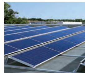
Montaje sobre cubierta plana
